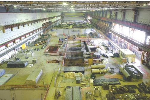
На ГП «Игналинская атомная электростанция» (ИАЭС) завершён демонтаж оборудования турбинного зала 1-го блока по проекту В9-1. Работы по демонтажу выполнялись с октября 2011 года по июль 2016 г. персоналом ИАЭС.
