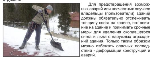
Для предотвращения возможных аварий или несчастных случаев владельцы (пользователи) зданий должны обязательно отслеживать толщину снега на кровле, его влияние на здание и принимать срочные меры для удаления скопившегося снега и льда с наружных ограждений зданий. Только таким образом можно избежать опасных последствий - деформаций конструкций и аварий.
